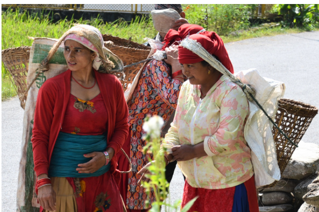
Bewohner helfen Steine für den Toilettenbau hochzutragen
