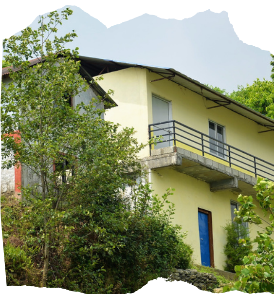
Die beiden Gebäude von Aussen
